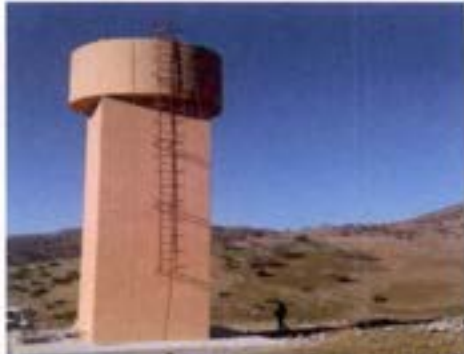
خزان ماني مجهز بمعدات الضخ بإحدى المدارس القروية
